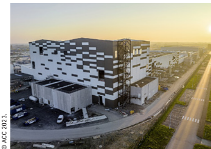
Voici l'usine géante de batteries qui a été inaugurée l'année dernière, près de Lens.
